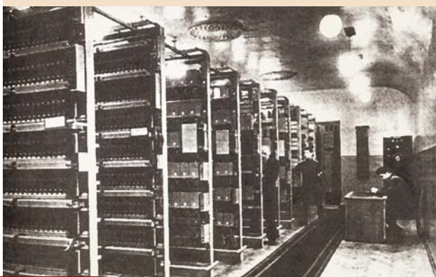
Московская станция ВЧ-связи.
