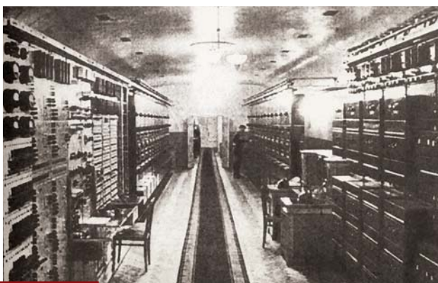
Московская станция ВЧ-связи.
