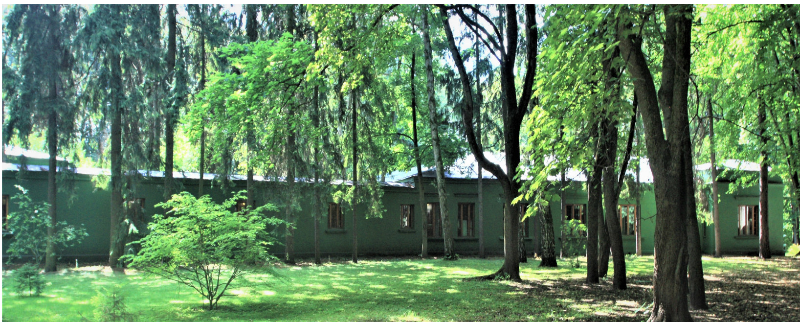
Служебное помещение (пристройка к Главному зданию)
