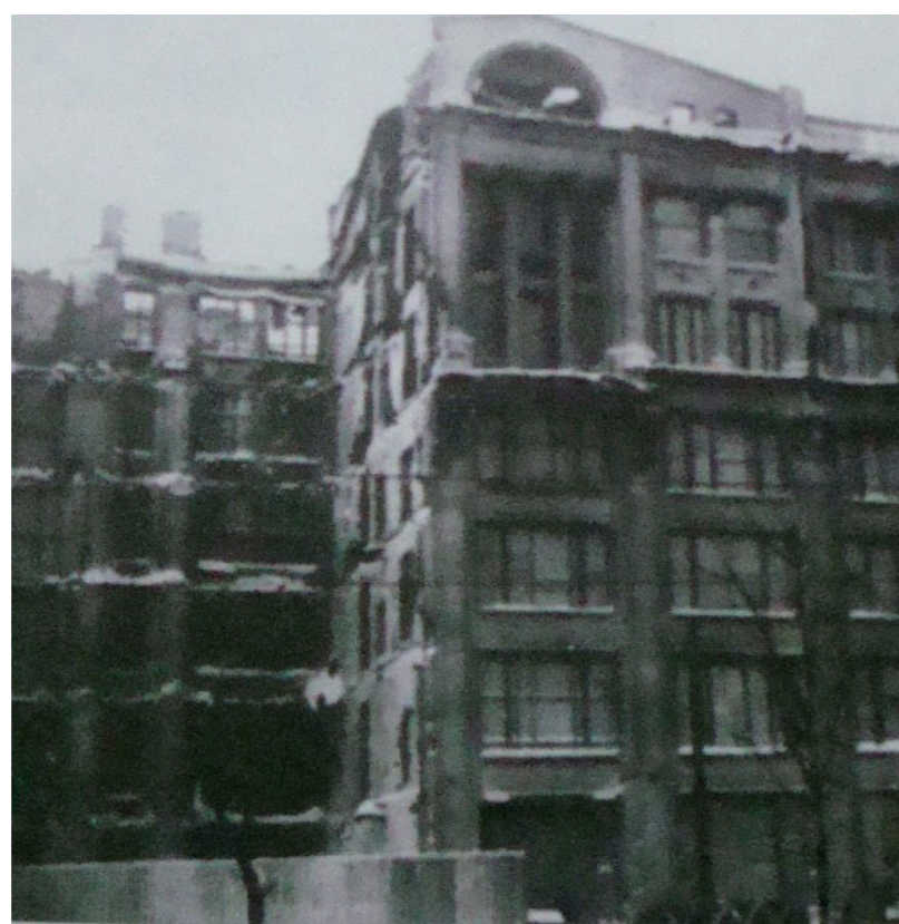
Поврежденное взрывом авиационной бомбы здание ЦК ВКП(б) на Старой площади. 1941 г.
