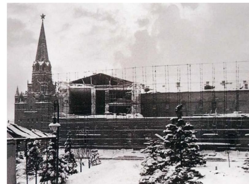
Поврежденное попаданием авиабомбы здание Арсенала Московского Кремля..
