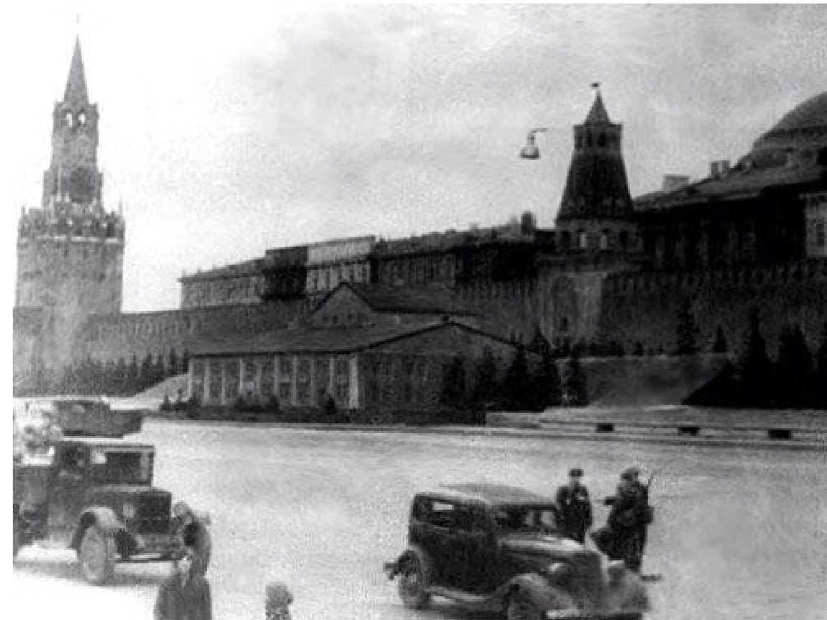
Объемная маскировка здания Мавзолея В.И. Ленина на фоне перекрашенных стен и башен Московского Кремля и фасадов кремлевских строений.
