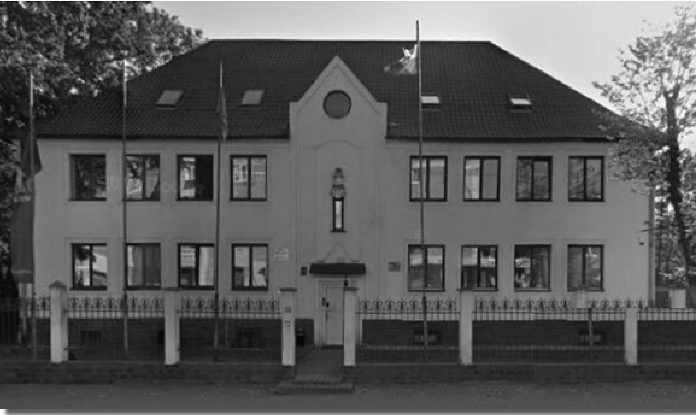
Фото: Немецкий особняк, в котором располагалось отделение правительственной связи в г. Калининграде
