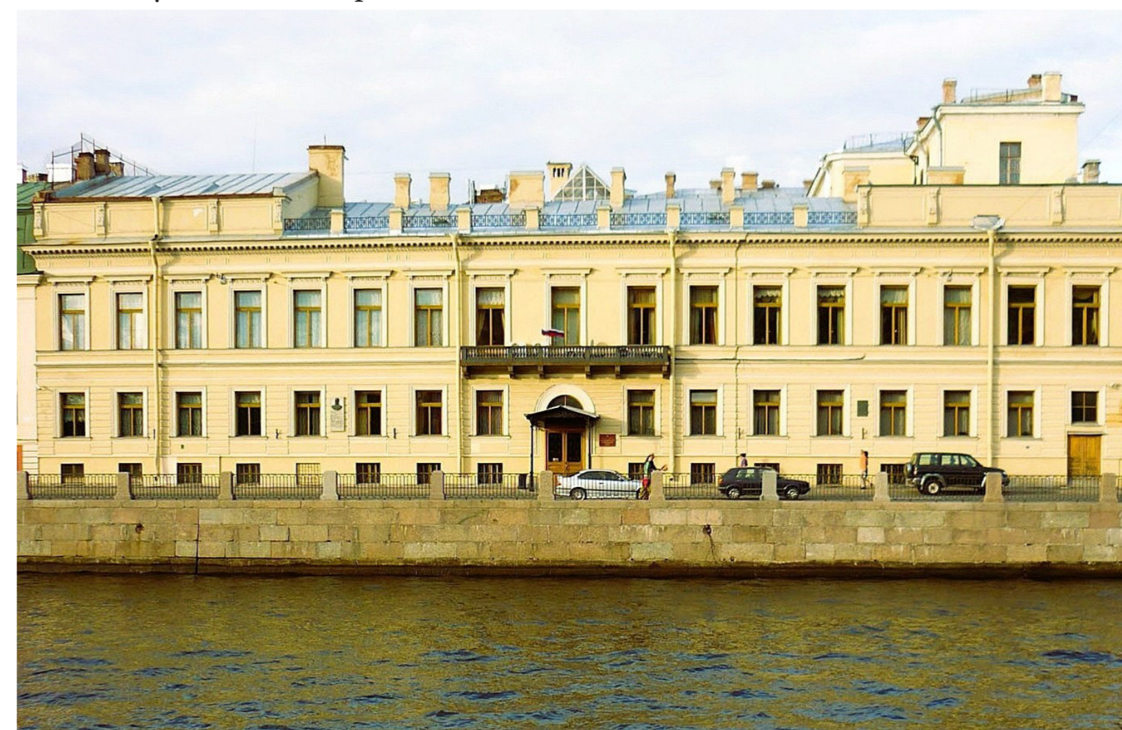
В этом доме № 16 на набережной реки Фонтанки, у Цепного моста, в 1838 году размещалось Третье отделение.
